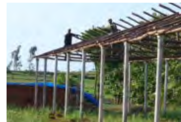
चित्र 2.1.2 चरण 1- छाया घर निर्माण 4
